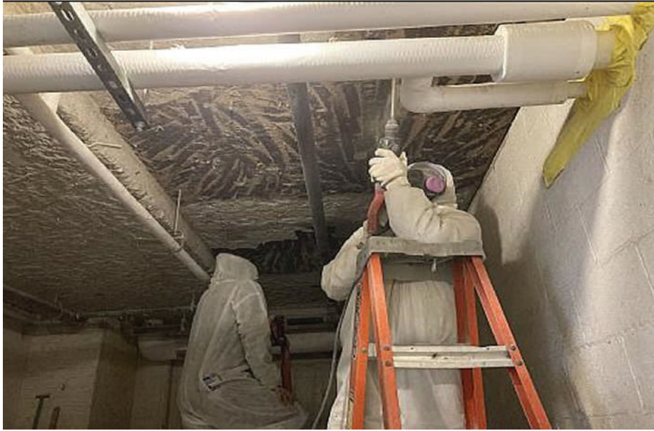
الشكل 5-8: صورة توضيحية لطريقة الحقن لإزالة الأسبستوس
