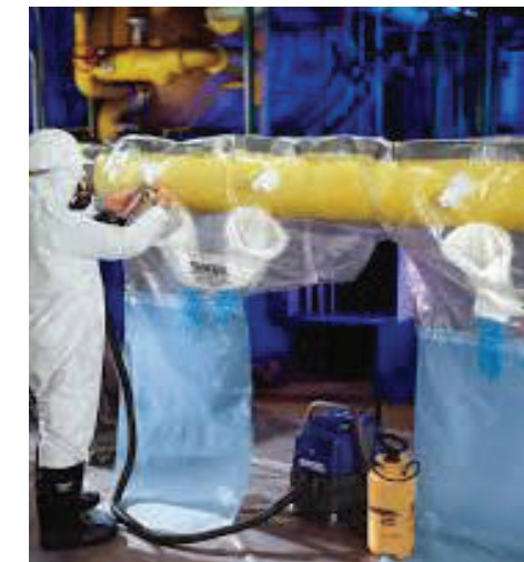
الشكل 5-7: صورة توضيحية لطريقة كيس القفازات لإزالة الأسبستوس
