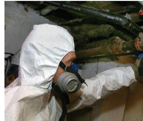
الشكل 5-6: صورة توضيحية لطريقة الإزالة الرطبة للأسبستوس
