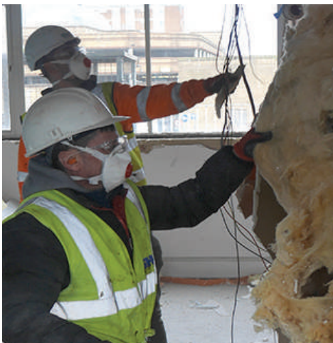
الشكل 5-5: إزالة التلوث وإزالة المواد الخطرة
