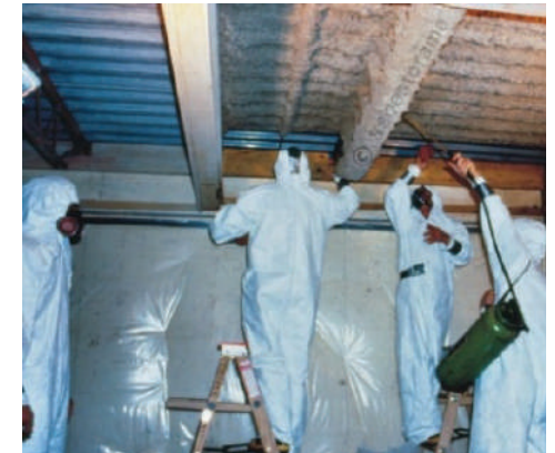
الشكل 5-6: صورة توضيحية لطريقة الإزالة الرطبة للأسبستوس
